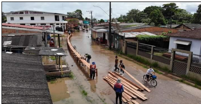
Figura 5 – Rua BH1 Nilo Pereira recebendo as construções de passarelas. Fonte: CNA7 (2021).
