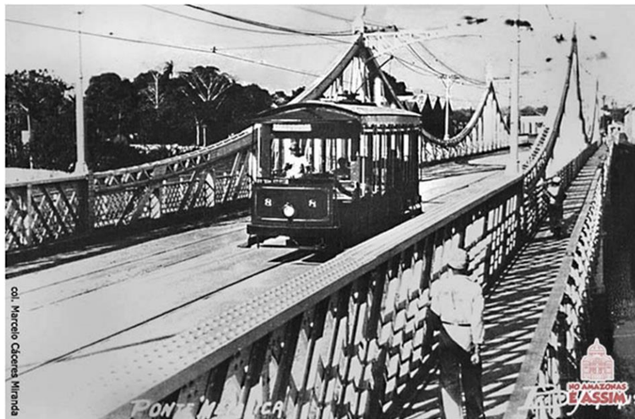
Figura 02: Ponte de ferro, Manaus,1950.
