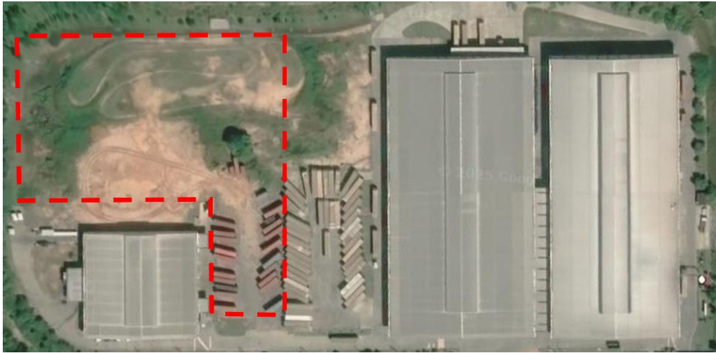
Figura 10: Vista aérea da área inutilizada
