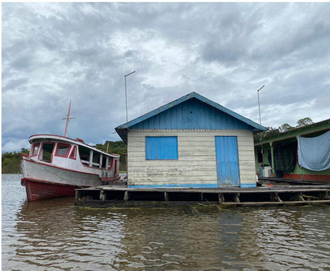
Figura 2 – Residências de casas flutuantes da comunidade de Janauacá, Careiro Castanho.
