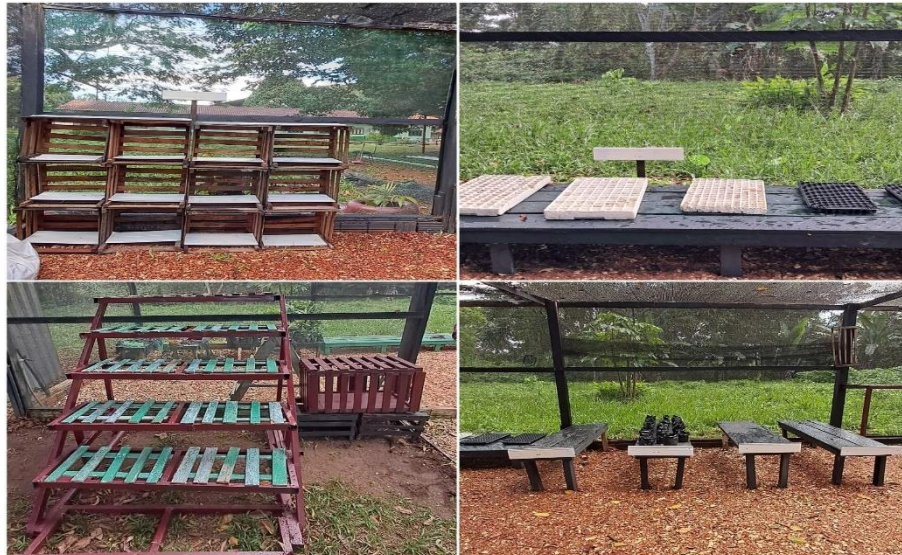
Figura 7 – Resultado da reforma das bancadas: estruturas organizadas, niveladas e prontas para o cultivo.
