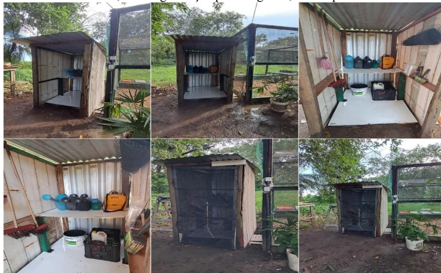
Figura 21. Estrutura finalizada destinada ao armazenamento ordenado de ferramentas e insumos. Vista externa e interna da estrutura finalizada, com organização por categorias, uso de prateleiras e cobertura segura.
