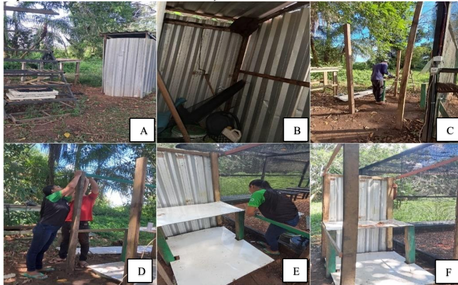
Figura 20. Etapas da reconstrução do depósito de materiais: A) Estrutura antiga, deteriorada. B a F) Etapas da reforma com reaproveitamento de materiais e instalação do telhado e fechamento lateral.
