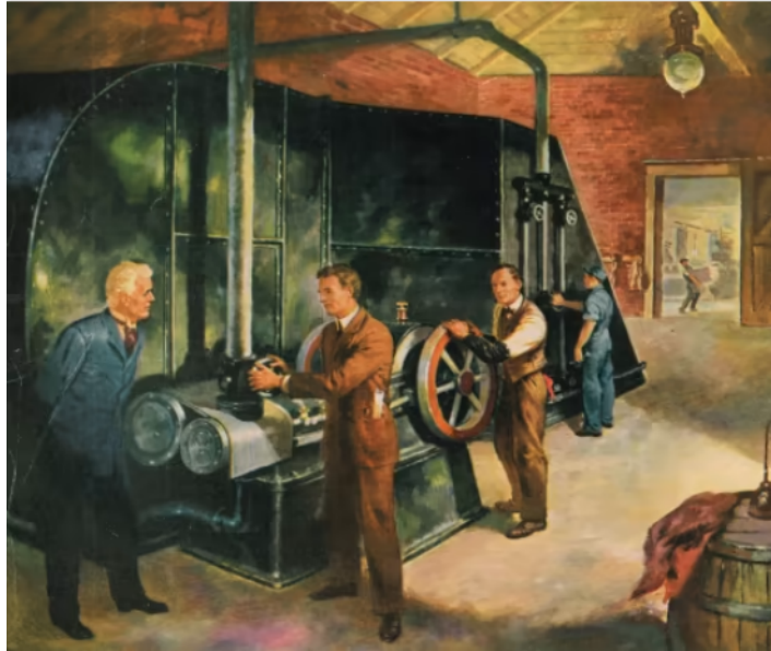
Figura 1 – Primeiro sistema de ar-condicionado.
