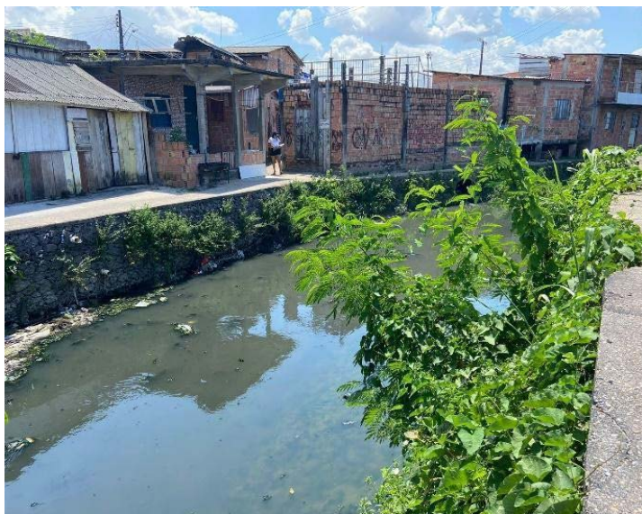
B: Gabião para contenção de margens no médio curso do Igarapé do Bindá
