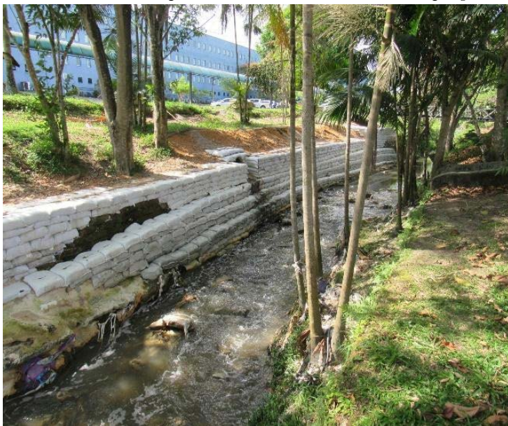
A: Método de contenção de margens – Universidade Nilton Lins
