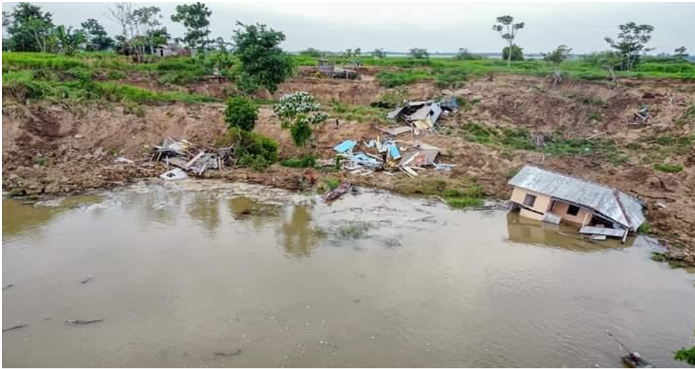
Figura 6 – “Terras Caídas” afetou a população que mora na comunidade São Francisco Xavier em Barreirinha-AM
