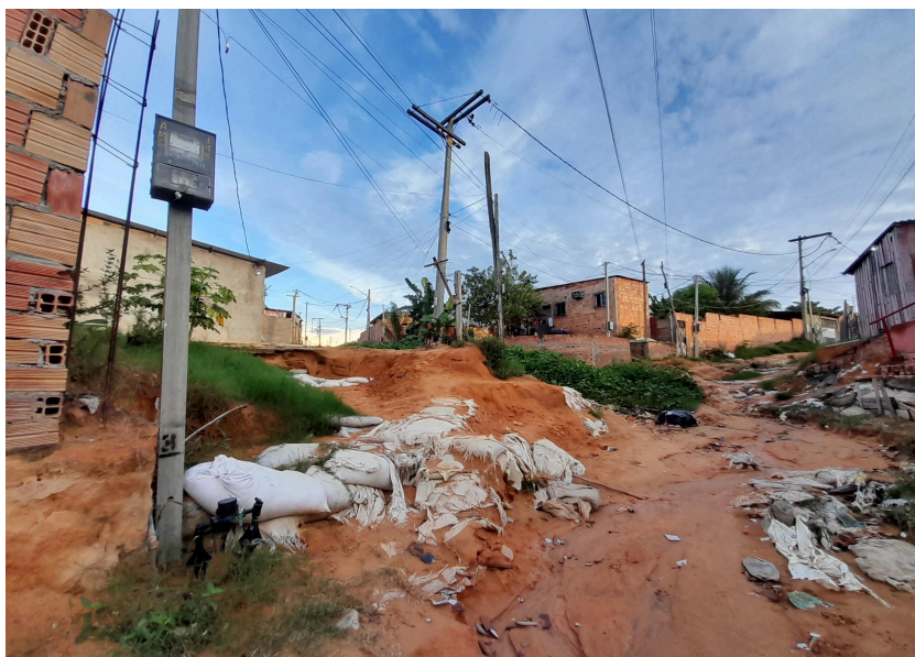
Figura 7: Problemas de infraestrutura da comunidade 2
