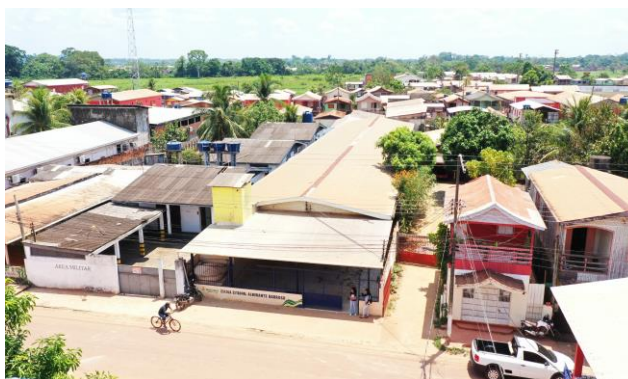
Figura 02 – Vista aérea da escola
